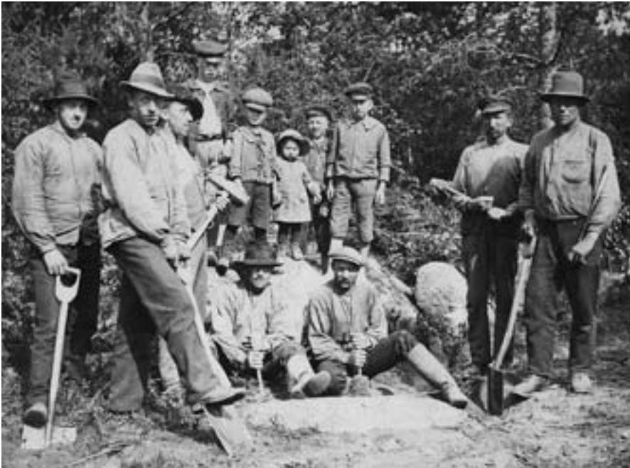
FIGUR 12. Vägarbete med barn som åskådare.
