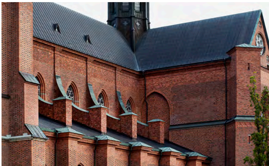
Fig. 18. Strävbågar och taklistor på domkyrkans södra sida, ombyggda under 1940-talet i anslutning till Östbergs restaureringsförslag. Foto: Olle Norling, Upplandsmuseet, Uppsala.
