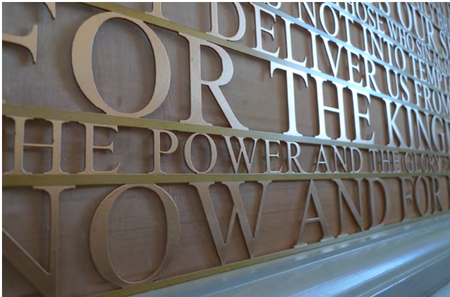
Fig. 4. Elementskydd i form av texttavlor med Herrens bön på olika språk. Bakgrunden är ett fintrådigt metallnät, texten är laserskuren ur plåt och målad så att den ska framträda tydligt. Barup & Edström arkitekter.
